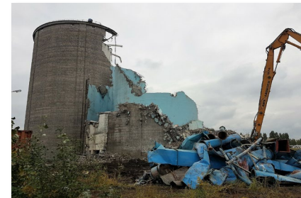
Abbau von Silos
